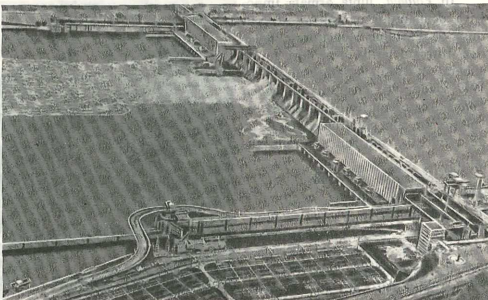
Hidrocentrala de la Porțile de Fier, construită în colaborare cu R.S.F. Iugoslavia.
