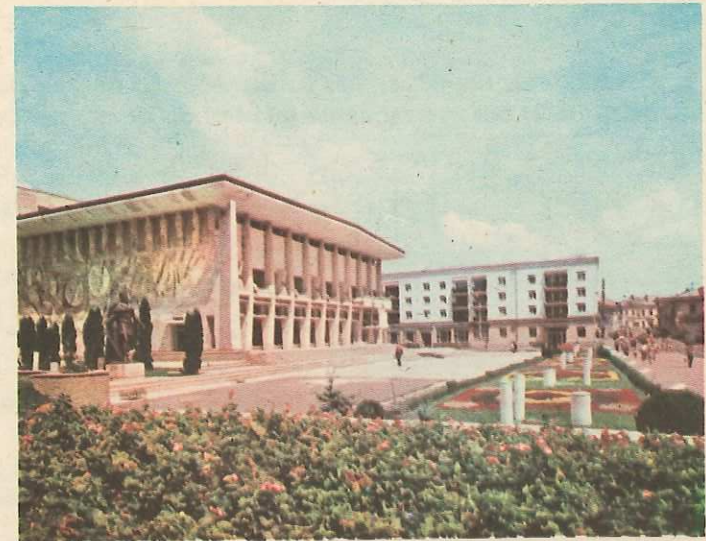
Fig. 49. Casa de cultură din Suceava.
