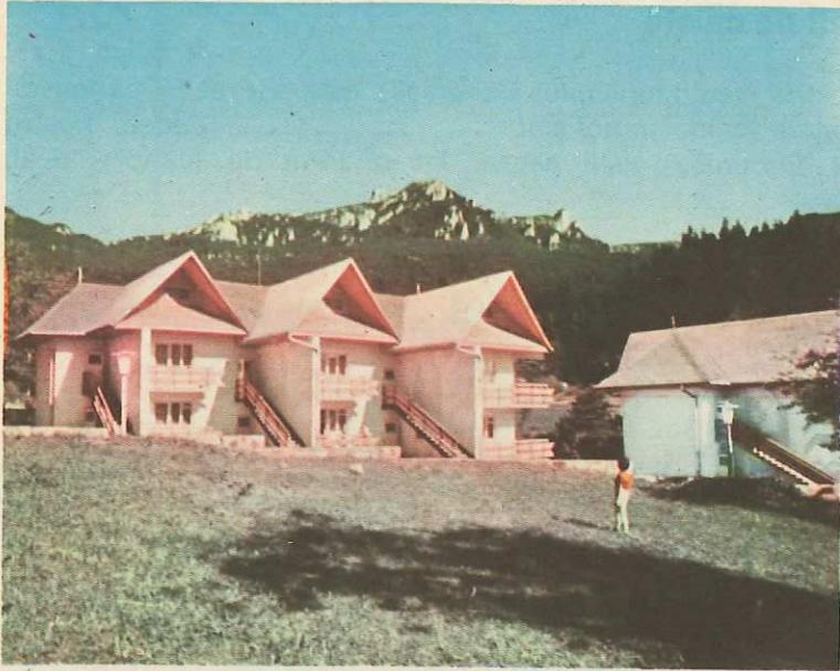
Fig. 52. Ceahlăul văzut din stațiunea Durău.
