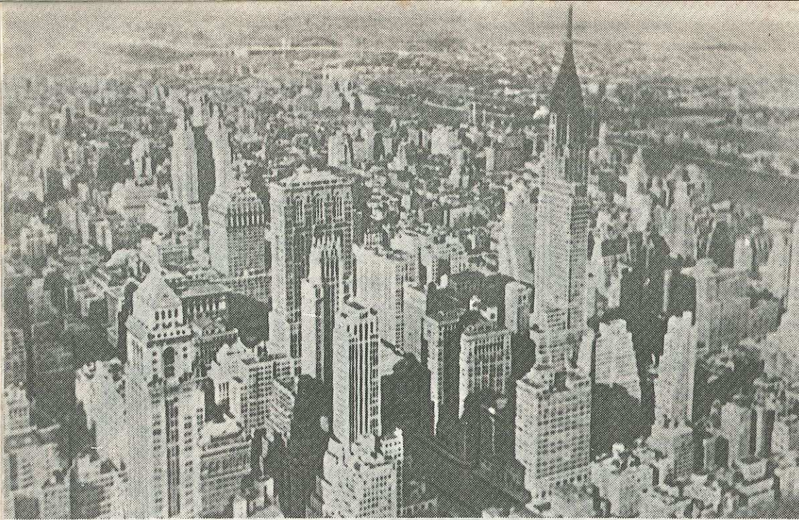
Fig. 79. Vedere din New York. Clădirile „zgirie nori” se înalță pe tot cuprinsul insulei Manhattan.
