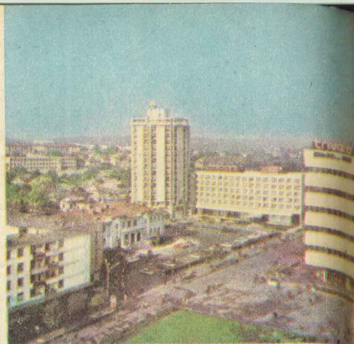
Construcții noi în orașul Pitești.
